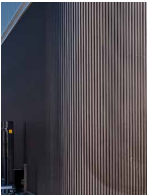
Paneelecken - gebogene Sandwichelemente
